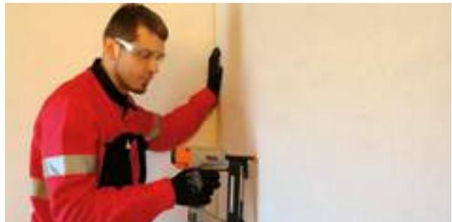
Abbildung 27: Verklammern von Platten.
