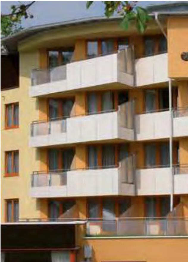
Die Befestigung ist mit Blindnieten als auch mit Balkonschrauben möglich. Unter Einhaltung von Fix- und Gleitpunkten werden die Platten auf Profilen aus Aluminium bzw. verzinktem Stahl montiert. Hierbei ist zu beachten, dass sich die Platten bei wechselnden Klimaten gleichmäßig ausdehnen können. An den Verbindungsstellen empfiehlt sich der Einsatz von elastischen Gummiprofilen aus EPDM.
