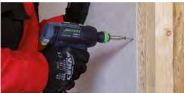
Abbildung 28: Befestigung mithilfe von Holzschrauben.
